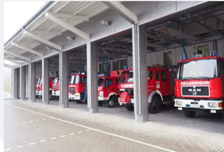
Feuerwehrgerätehaus Braunlage, Deutschland
